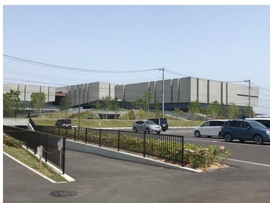
プールとアリーナの外観(超立派)。
