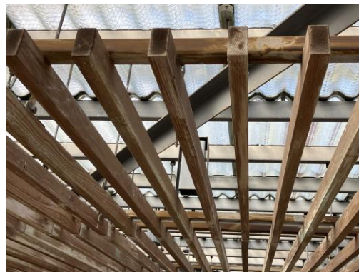
屋根が掛かっている所は綺麗なまま。
